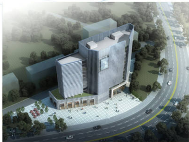
汇才大厦岩土工程详细勘察
