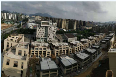
桂林医药城D-5地块（波尔多湾）一期基坑支护设计
