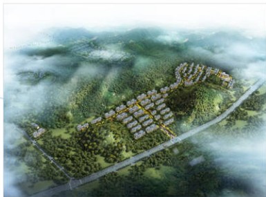
彰泰·伴山云岩土工程详细勘察和施工勘察
